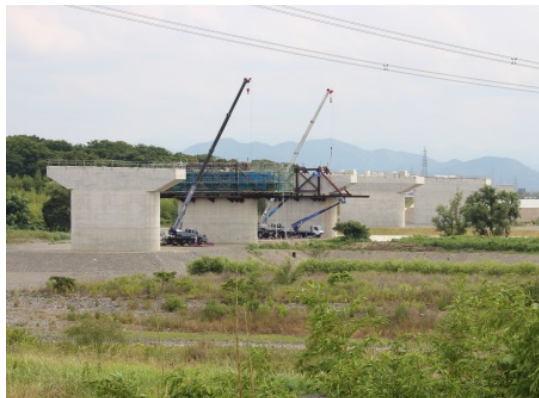
【揖斐川渡河部(写真①)】 平成26年6月撮影
