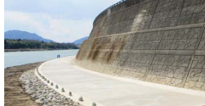
木曾川美濃加茂水辺整備 (散策路、親水護岸等の整備)
