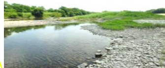
木曾川一宮北部水辺整備 (散策路、高水敷等整備)
