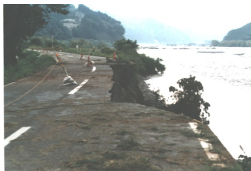
平成3年9月洪水 俵沢地区（21.5k付近左岸）被災状況
