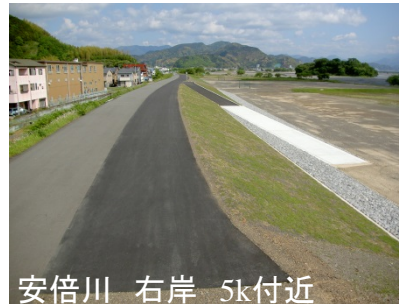
堤防強化(手越地区)
