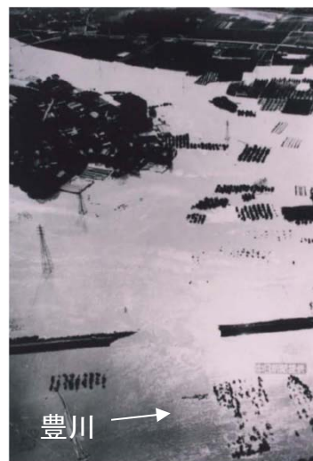
江島地区の堤防の決壊(昭和44年8月)
