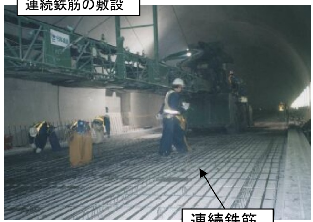
スリップフォームによる連続的な打設
