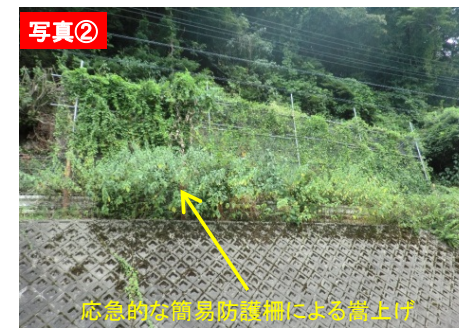
簡易防護柵による嵩上げ.H25現地調査結果
