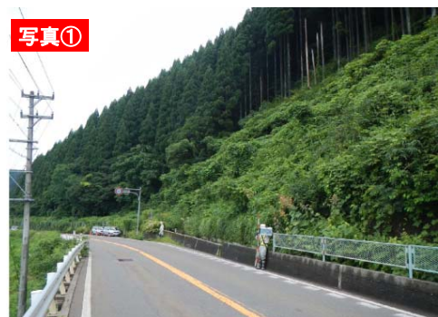
写真① 全景(起点). H25防災点検結果
