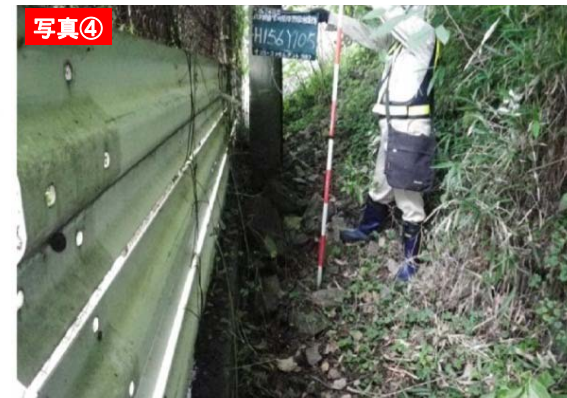
応急対策としてガードレールを設置. H24防災点検結果
