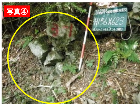
中腹部以高は浮石が各所に点在。H24防災点検結果
