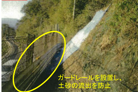
写真② ■対策後の状況(H16.11)
