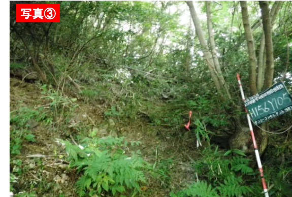
終点側の表面崩壊地. H24防災点検結果
