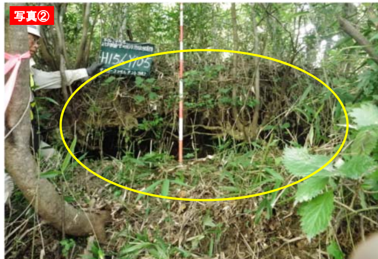
起点側の表層崩壊地(頭部). H24防災点検結果
