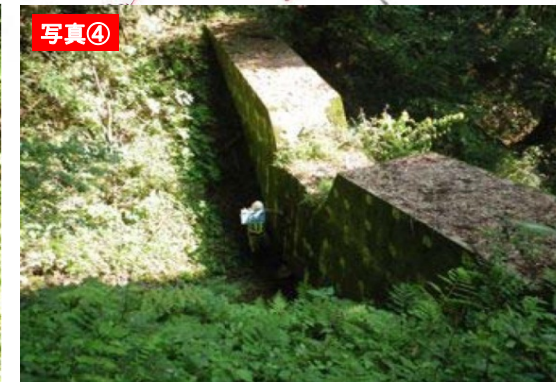
谷止め工の状況. H24防災点検結果
