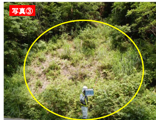
写真③ 表層崩壊地の状況(豪雨の際には道路に影響する土石流が発生する可能性あり) H25防災点検結果
