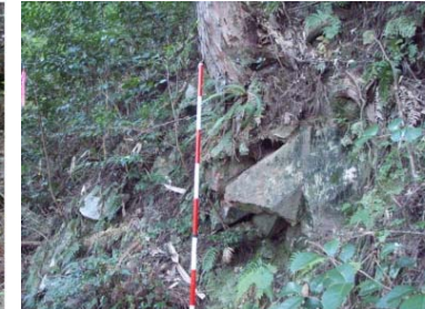
箇所5(A164): 落石・表層崩壊
