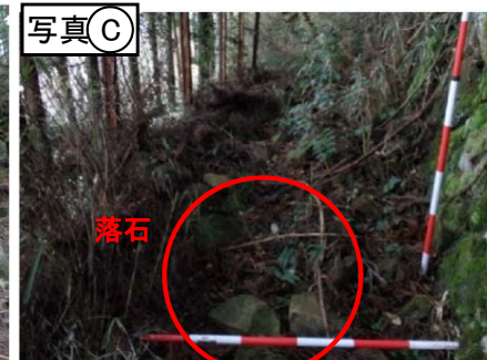
ストーンガード背面の落石
