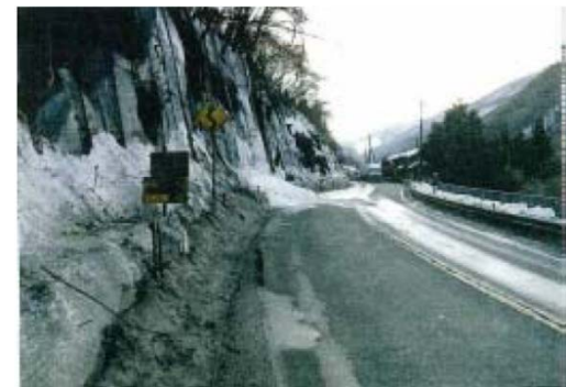
写真④ H13.2.19 大雪による雪崩発生
