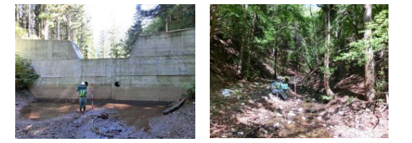
写真④: D防災カルテ箇所(レベルⅡ)(擁壁) ・擁壁隙間湧水 ・擁壁基礎部の破損
