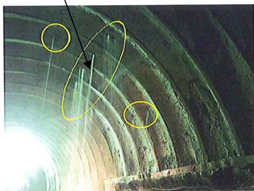
坑内での湧水状況(他工事事例)
