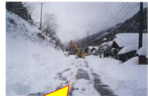
写真③ H10.1.15 大雪による雪崩発生
