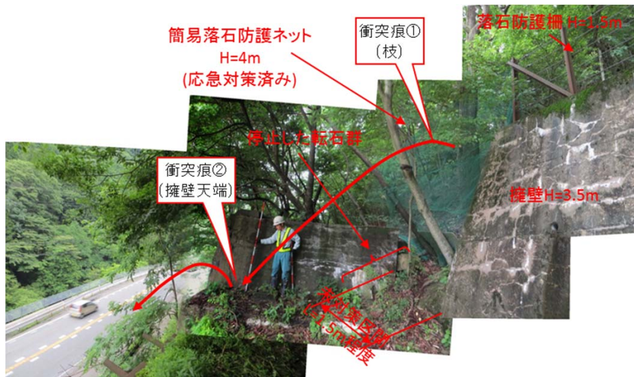
写真 既設道路沿い擁壁天端部を起点側より望む
