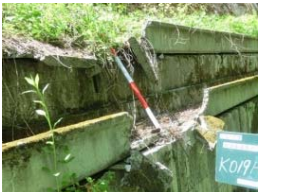
写真④: D防災カルテ箇所(レベルⅡ)(擁壁) ・擁壁隙間湧水 ・擁壁基礎部の破損
