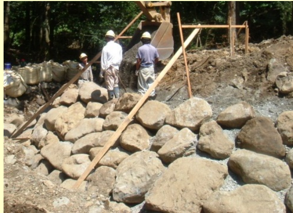
施工時の状況
