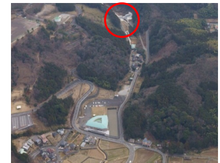
まえのさわ 前の沢砂防堰堤 (H23年度完成)
