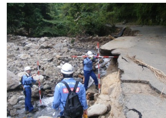
土砂災害時の自治体支援 (H25.7 西伊豆町)
