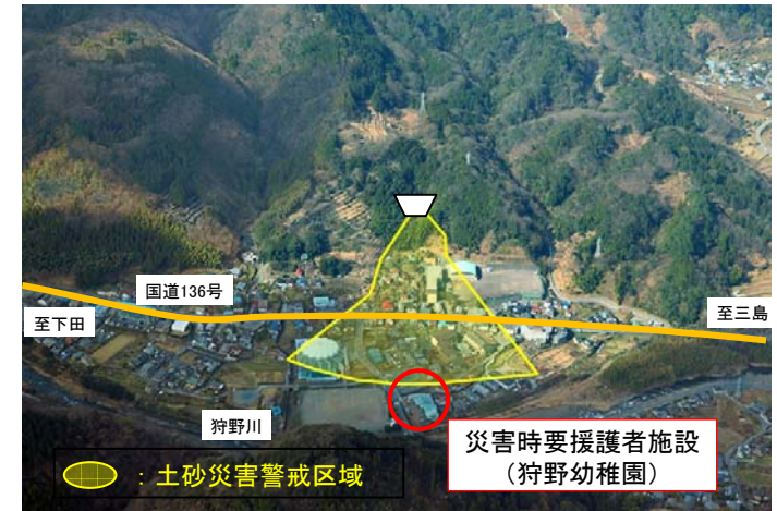
土石流危険渓流「入の洞」と災害時要援護者施設
