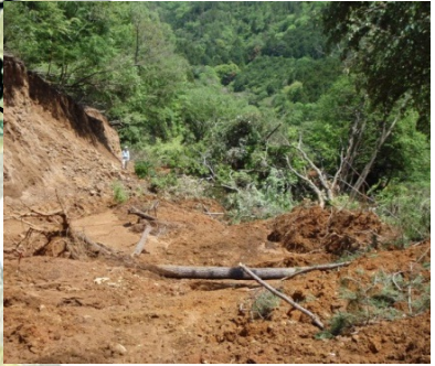
しもおのがわ 下尾野川での表層崩壊 (H24.5大雨)
