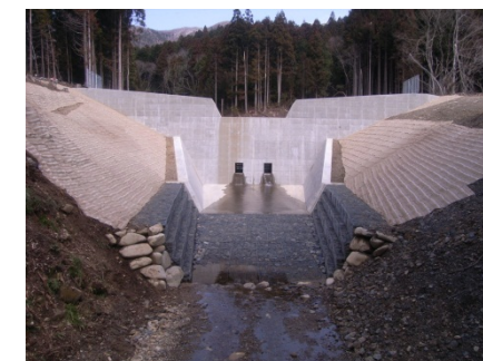
ひぼら 日洞第1砂防堰堤(H24年完成)
