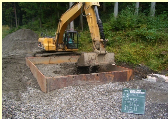
土砂の搬入状況
