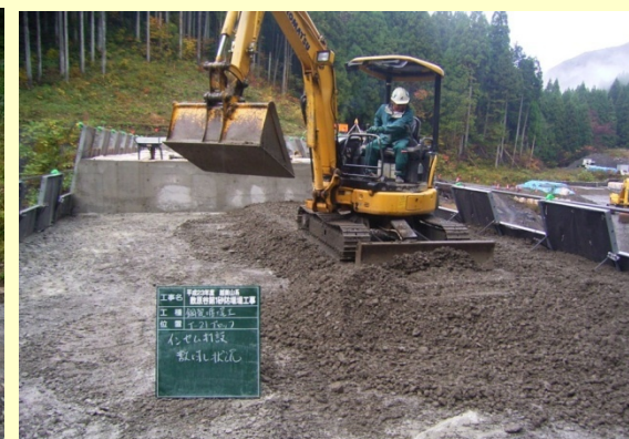
土砂とセメントの攪拌状況
