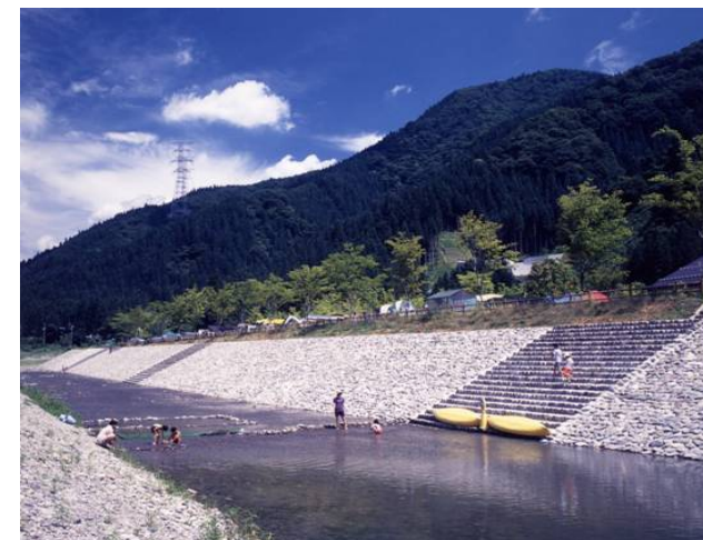
水と緑の溪流学校の拠点となっている大須床固工群
