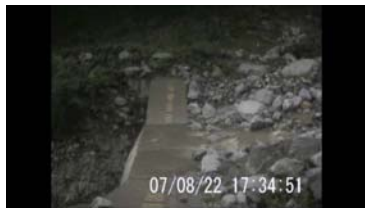
オンボロ沢の土石流発生状況
