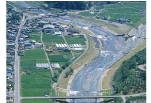
大河原床固工群(H23年度完成) (小沢川流域)
