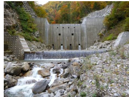
中田切第4砂防堰堤(H22年度完成) (中田切川流域)
