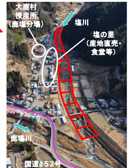
塩川床固工群周辺
