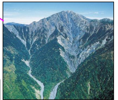
荒川大崩壊地
