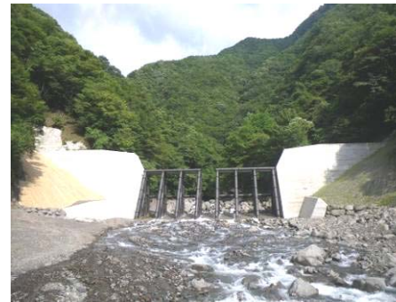
梶谷第4砂防堰堤(H22年度完成) (遠山川流域)
