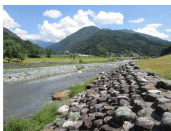
緩傾斜化した護岸
