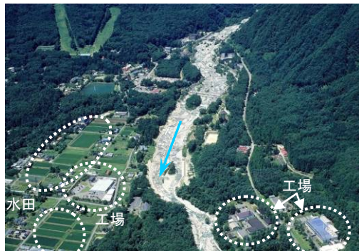
太田切床固工群
