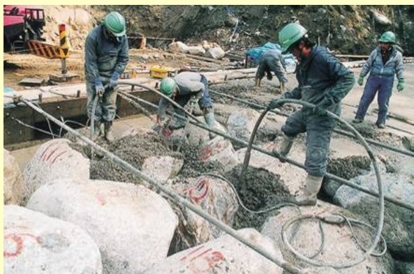
玉石の間への コンクリート打設状況
