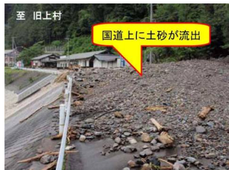
国道への土砂流出
