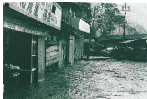
商店街(昭和通り)の氾濫状況
