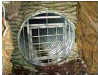
TL-34横坑坑口
