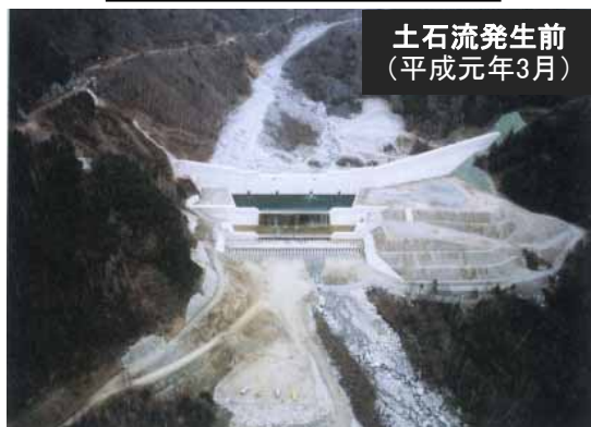
砂防堰堤の捕捉状況
