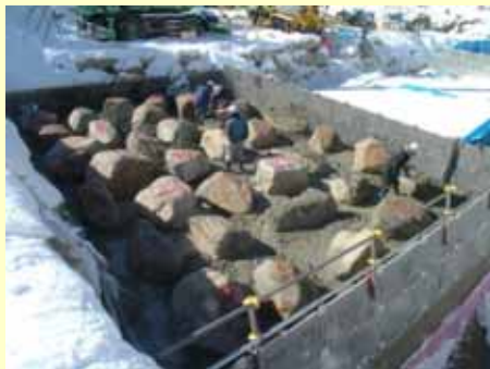
粗石コンクリート工法の施工事例(額付第2砂防堰堤)
