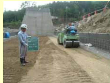
砂防ソイルセメントを利用した堰堤工
