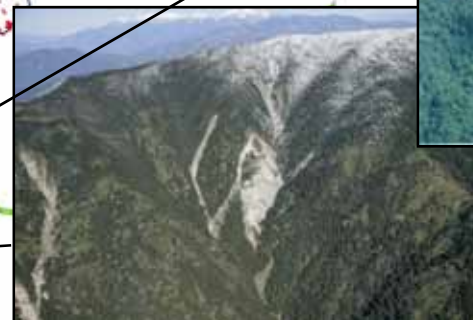
中津川支川一の沢の崩壊状況
