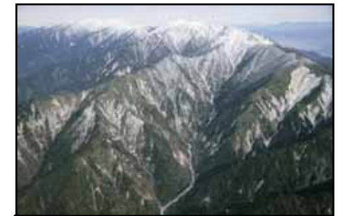
伊奈川上流の崩壊状況
