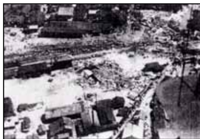
中津川市内の被災状況
