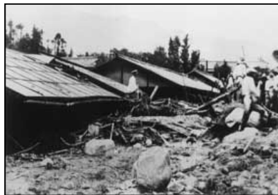
中津川市内の被災状況
