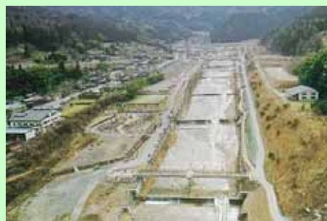
床固工で河床を安定させることにより河道周辺での土地利用が可能となった。
