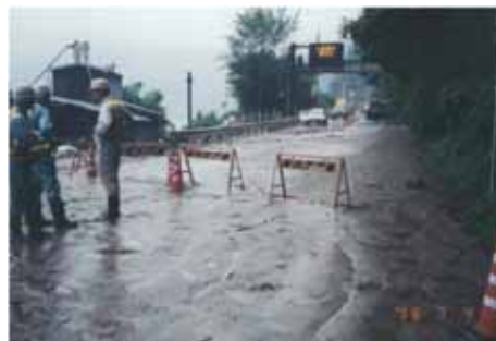
国道19号への土砂流出状況
