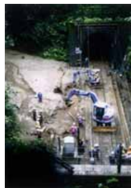
J R線の復旧作業状況
