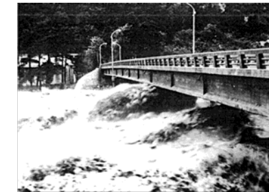
南木曾橋の主桁にせまる濁流 ＜出典：「中部の水害」＞
