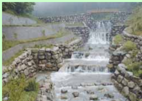
地域環境に配慮した島田床固工群
