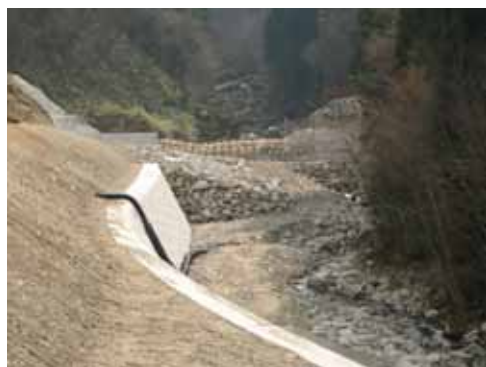
橋ヶ谷第2砂防堰堤（施工中）
