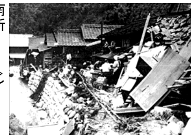
土石流に破壊された人家
