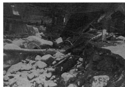
川上地区の被災状況 ＜出典：「50年の歩み」＞
