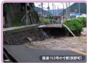
平成18年7月洪水の被害状況
