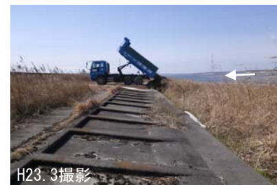
H23. 3撮影 建設発生土の干潟再生への利用 (0.6k左岸付近)
