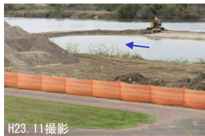
H23. 11撮影 河道掘削土の活用によるコスト縮減 (上塚橋下流付近での工事)
