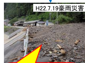
国道152号土砂流出
