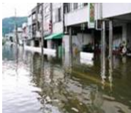
H18.7災害 諏訪市上諏訪地区
