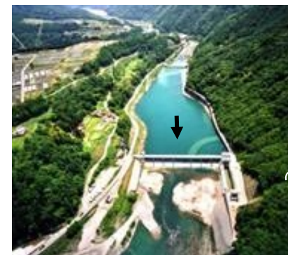
分派堰・土砂バイパストンネル
