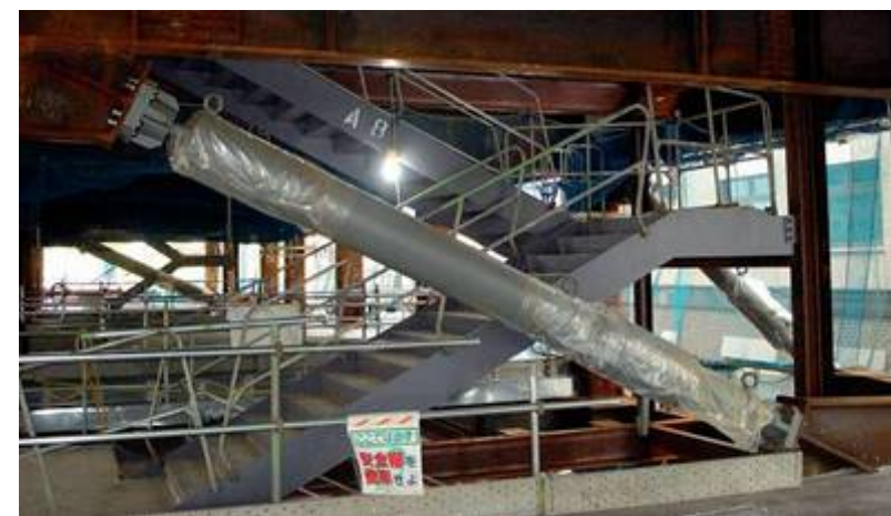
制震オイルダンパーブレース採用
