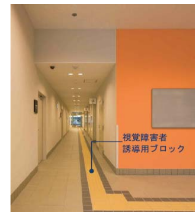
視覚障害者誘導用ブロック 両脇に明度差のある床材を設置し、認識しやすさに配慮
