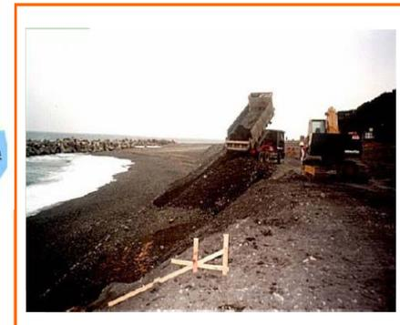
掘削土砂の有効活用イメージ(静岡海岸養浜工事)
