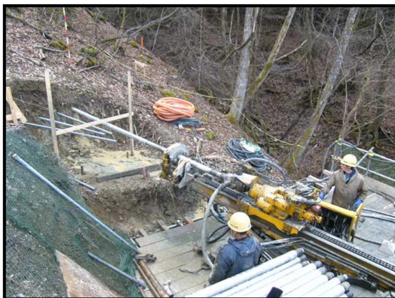
横ボーリング工施工状況（Fブロック）
