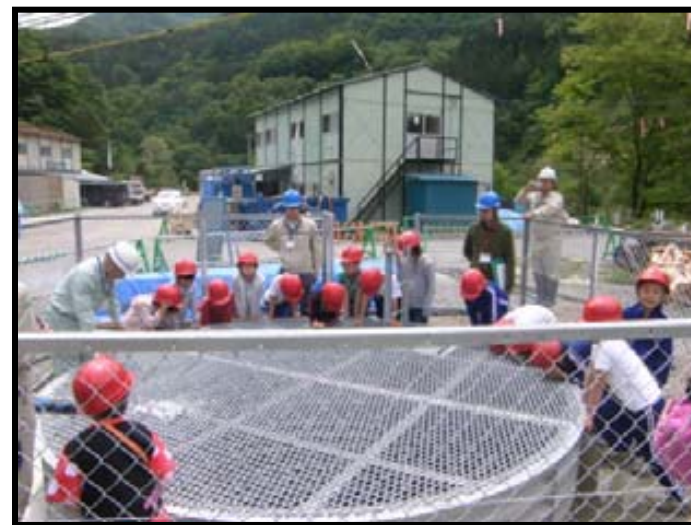
大鹿小学校による工事見学会
