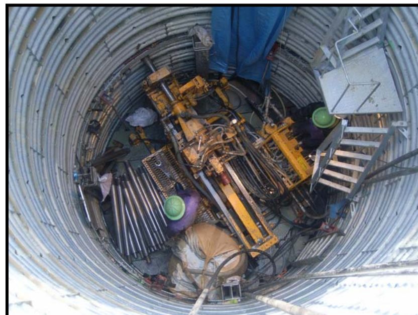
集水井工施工状況（Gブロック）
