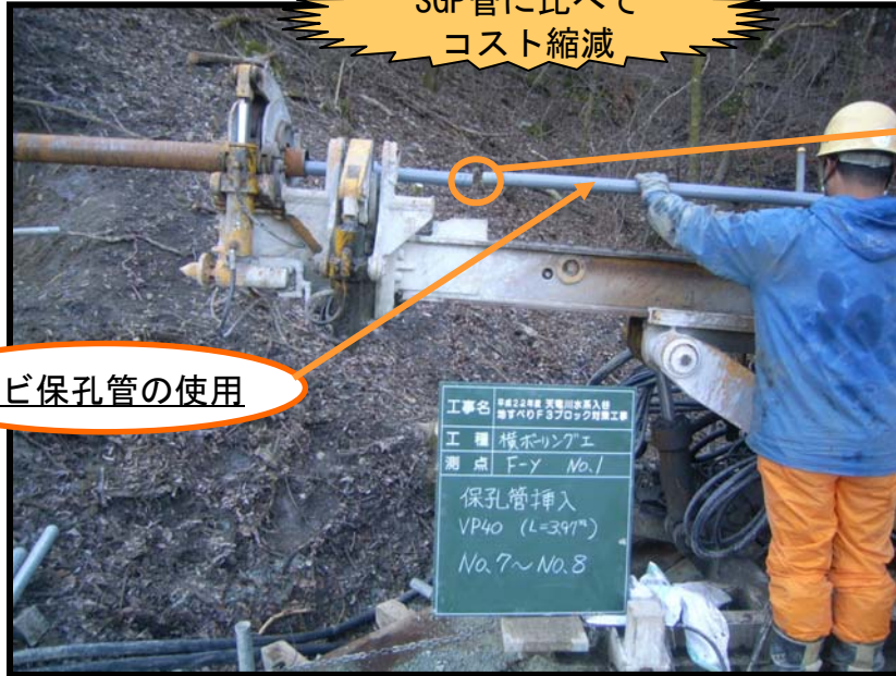
横ボーリング工の施工状況
