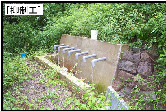
[抑制工] 横ボーリング工による排水の状況
