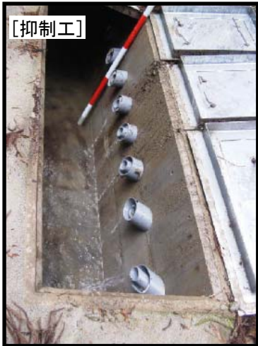
横ボーリング工による排水の状況
