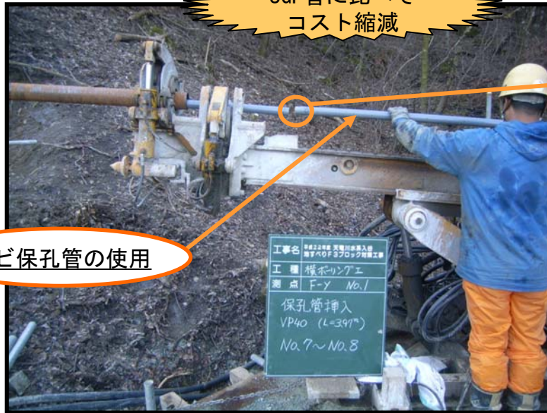
横ボーリング工の施工状況
