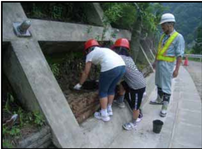
上村小学校による工事見学会
