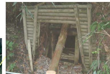
日影沢金山坑道跡
