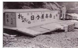
土石流により被災した梅ヶ島温泉
