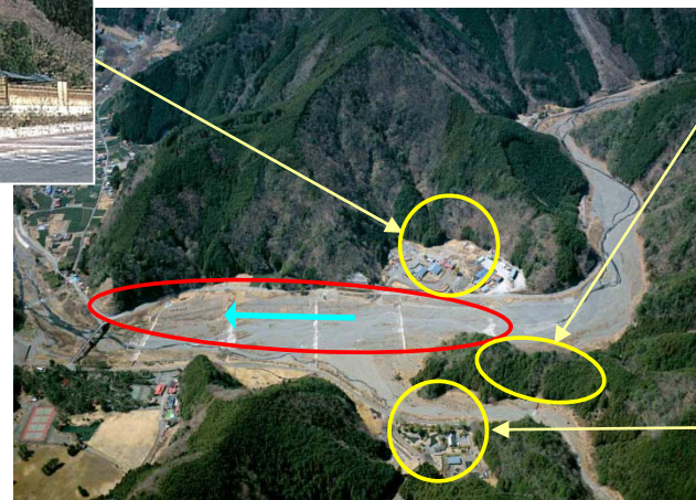
三河内川床固工群
