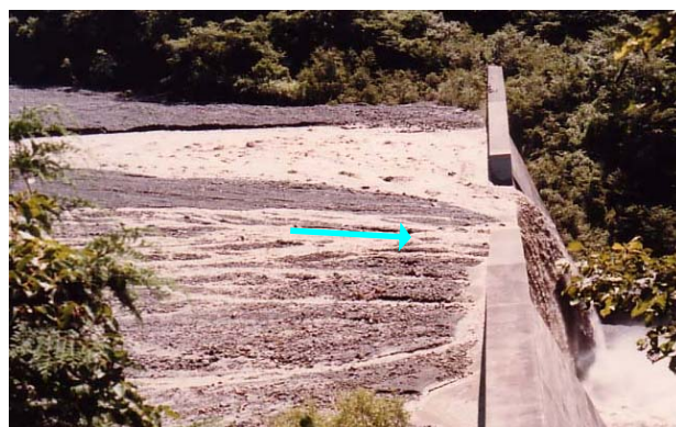
大島砂防堰堤(昭和57年撮影)
