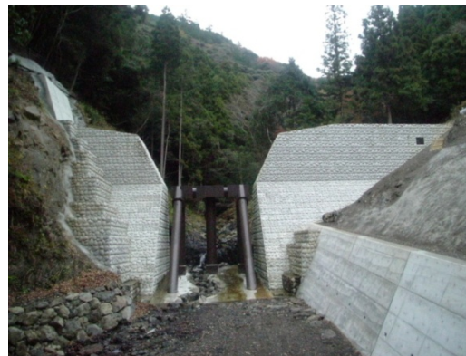
中尾沢砂防堰堤
