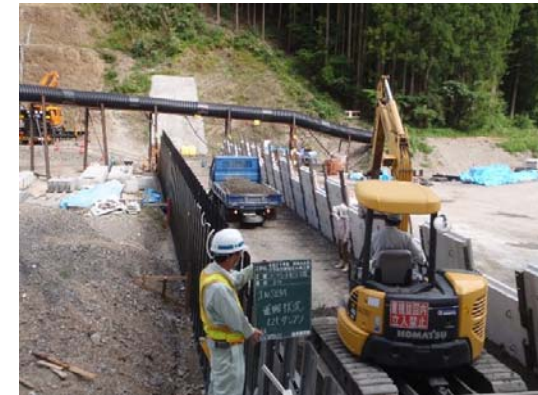
混合材料の運搬状況
