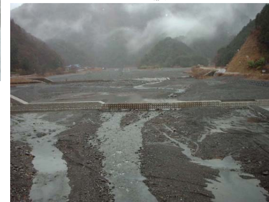
三河内川床固工
