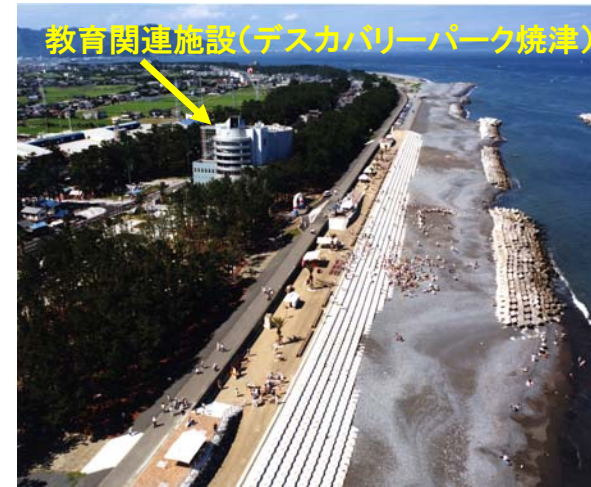
教育施設と一体で整備した海岸堤防(焼津工区)
