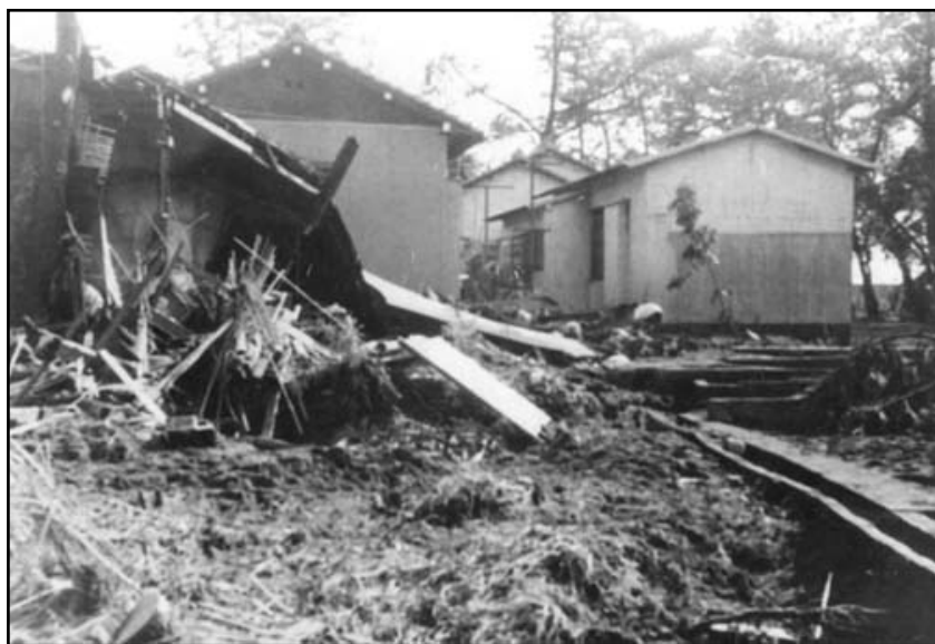
昭和41年9月 台風26号 高波・浸水により被災した家屋 (焼津工区田尻地先)
