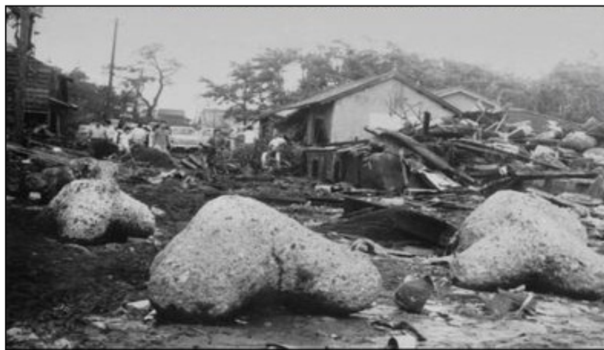
昭和41年 台風26号 高波、浸水により被災した家屋 (吉原工区今井地先)
