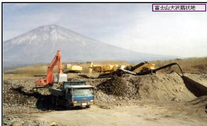
大沢川遊砂地における養浜材の採取状況
