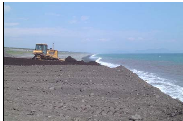
吉原工区における養浜工の施工状況
