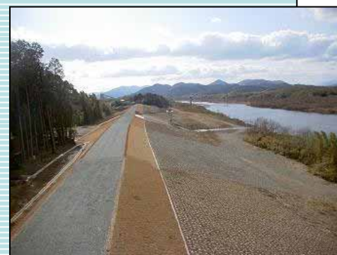
堤防整備(宮川右岸8.2k付近)
