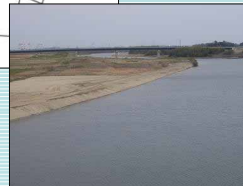
河道掘削(雲出川6.6k付近)
