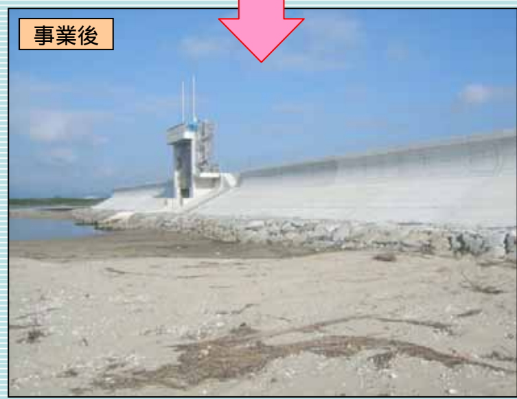
既実施の高潮堤防整備状況(雲出川左岸)
