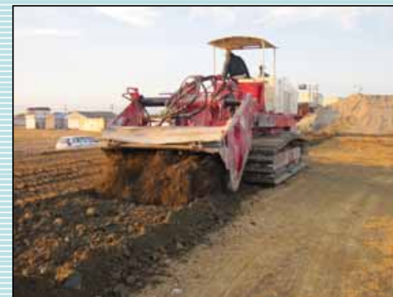
掘削土の有効活用 (購入土との混合攪拌状況)
