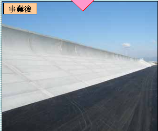
既実施の高潮堤防整備状況(鈴鹿川派川右岸)
