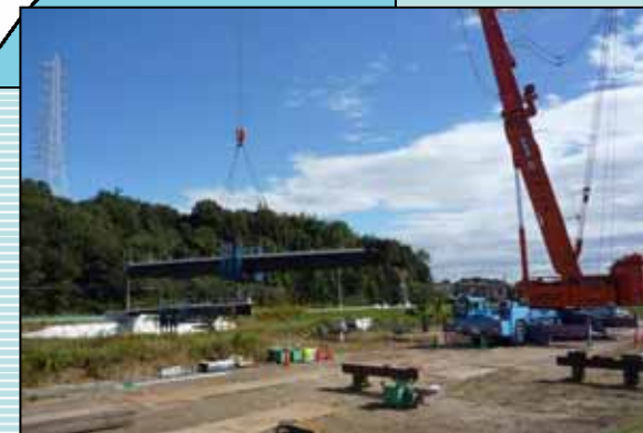
橋梁改築(内部川4.0k付近:矢矧橋)
