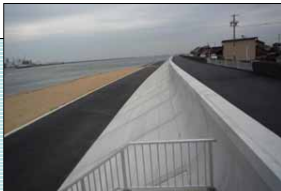
高潮堤防整備(鈴鹿川左岸0.2k付近)
