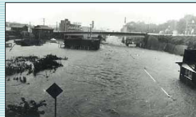
昭和49年7月洪水 浸水状況(亀山市駅前)
