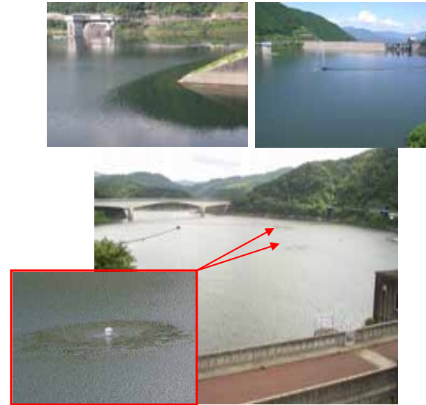
曝気循環設備稼働状況
