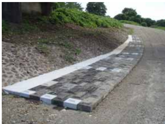
連節ブロックの発生品の再利用(橋脚防護工)
