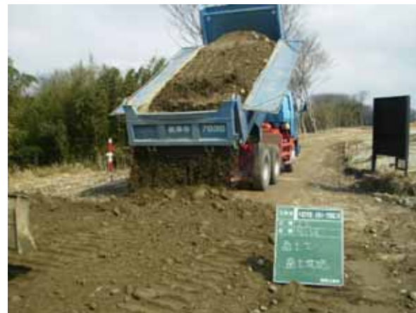
路盤材の採取土利用
