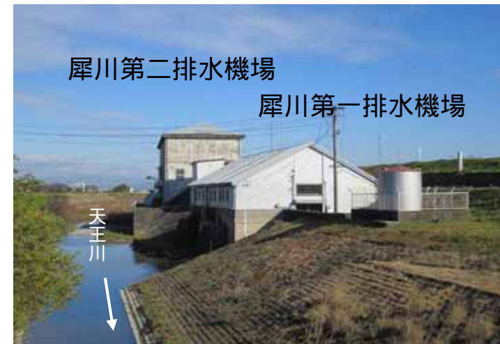
現在の犀川第一排水機場・犀川第二排水場
