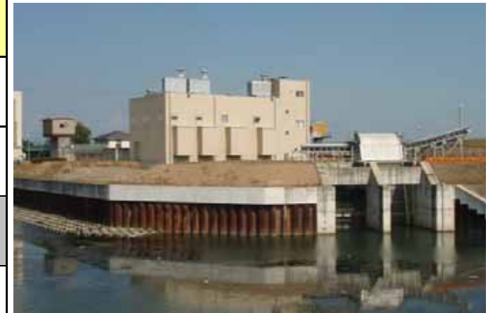
現在の犀川統合排水機場
