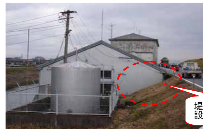
犀川第一排水機場と堤防との関係
