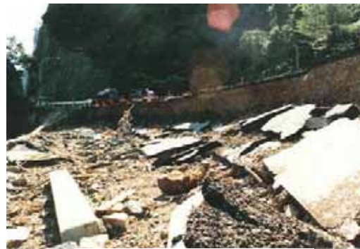
坂祝町内 被災状況
