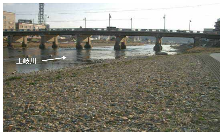
平常時の状況(多治見橋右岸上流)
