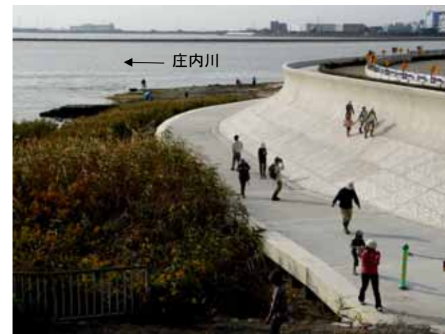
➤ 管理用通路の利用状況。
