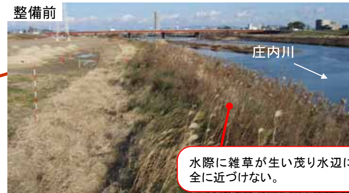
管理用階段の整備
