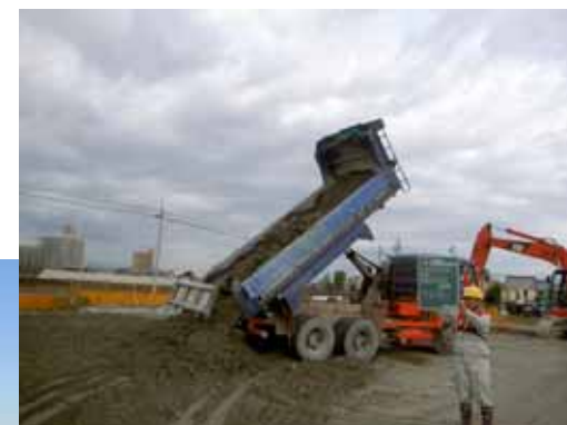
掘削土受入地搬入状況
