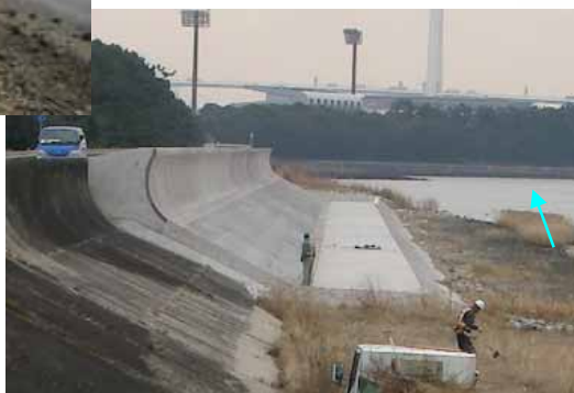
改築後の状況 (0.0k付近)
