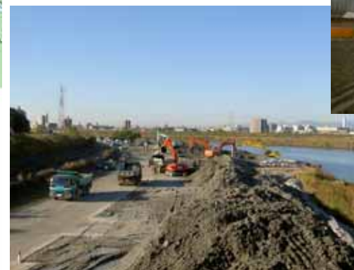
掘削土搬出状況
