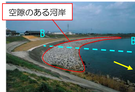
(整備後の河岸部)
