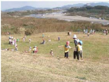
コンクリート上に土を覆い、草を植栽したことによって、自然にふれあえる環境となりました。
