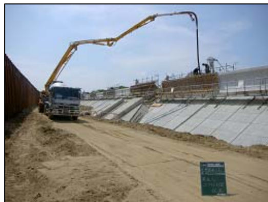
老朽化対策 (堤防改良状況)
