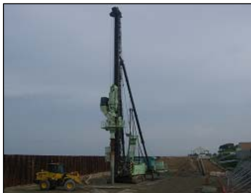
液状化対策 (地盤改良状況)
