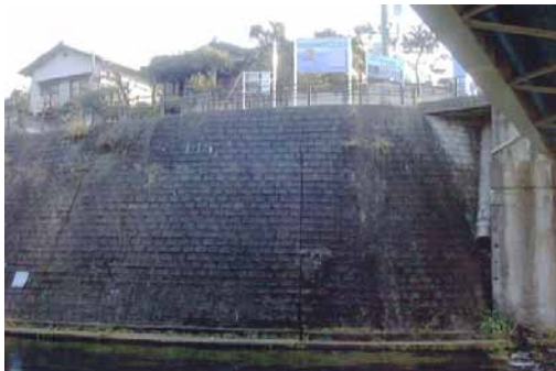
コンクリート護岸（H12頃）
