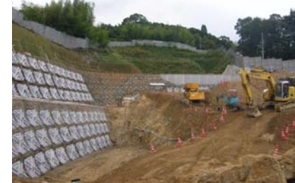
【改良区間進捗状況】
