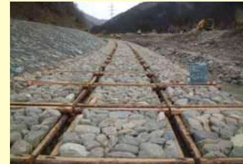
間伐材料と現地発生材料(玉石)を利用した根固工
