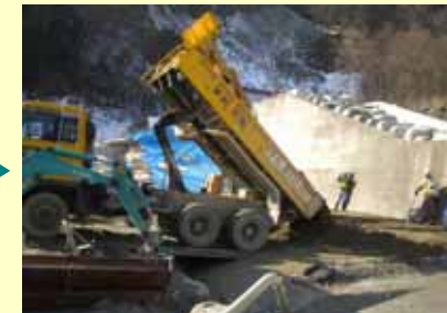
混合材料の運搬・荷下ろし
