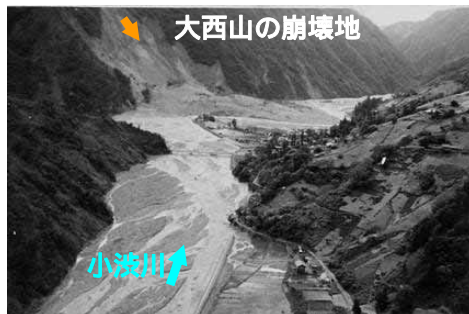
大西山の大崩壊により 被害を受けた大河原地区
