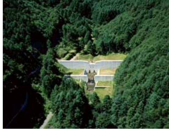
鉢伏沢砂防堰堤 (H17年度完成) (三峰川流域)
