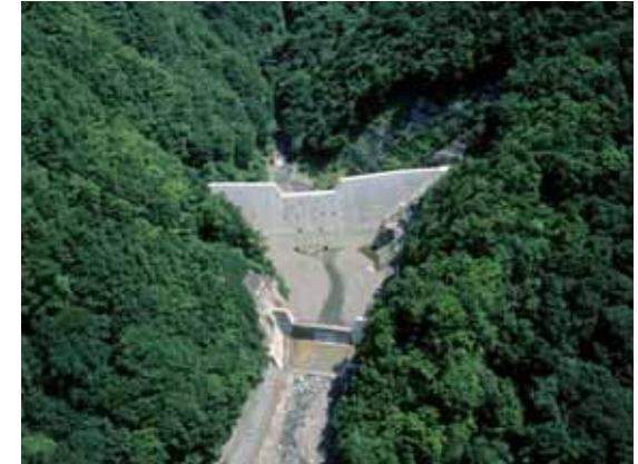
兔洞沢砂防堰堤 (H18年度完成) (遠山川流域)
