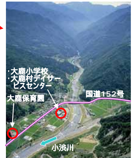
大河原床固工群周辺
