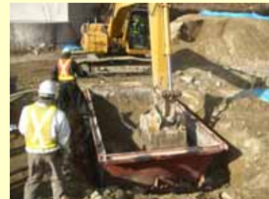
土砂とセメントの混合
