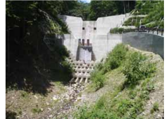
堀破沢砂防堰堤 (H18年度完成) (小渋川流域)
