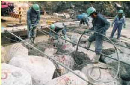
玉石打設状況
