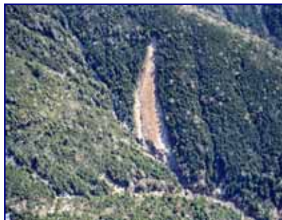
北御所谷の新規崩壊 (H15年4月土石流発生)
