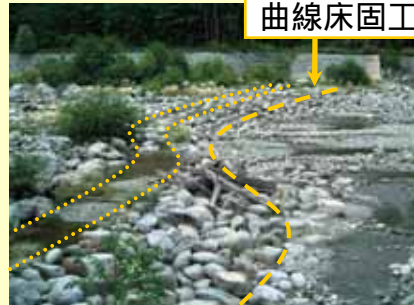
巨石を用いた曲線床固工
