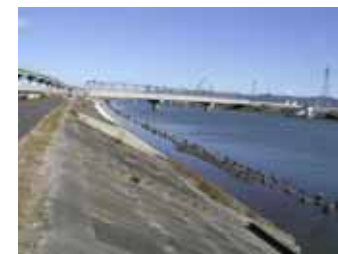
整備前の放水路の状況 放水路1.8k付近
