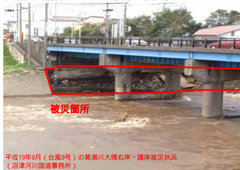
平成19年9月（台風9号）の黄瀬川大橋右岸・護岸被災状況
