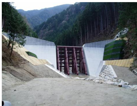
木曾川梨子沢第1砂防えん堤(透過型)
