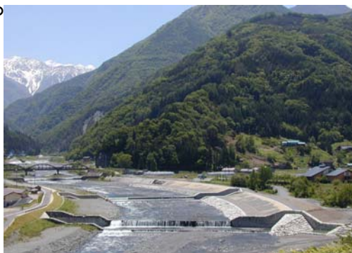
天竜川大河原床固工群
