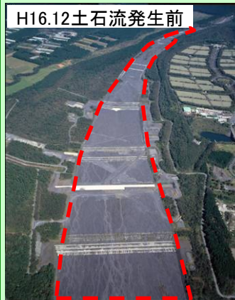
平成16年12月5日に連続的に土石流が発生。土石流は、大沢川遊砂地で捕捉され、下流域への被害を未然に防止。
