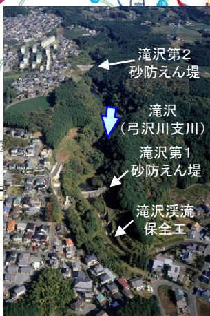
滝沢第1, 第2砂防えん堤, 滝沢溪流保全工
