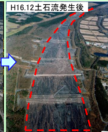
平成16年12月5日に連続的に土石流が発生。土石流は、大沢川遊砂地で捕捉され、下流域への被害を未然に防止。
