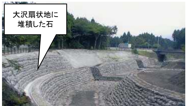
現地発生材を利用した護岸整備
