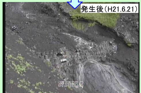
平成21年6月21日の土石流を捕捉。
