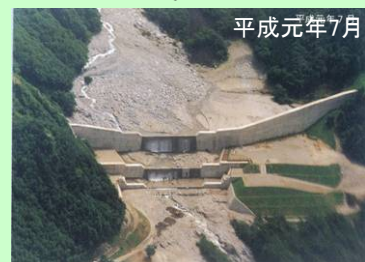
土石流発生直後の堆砂状況
