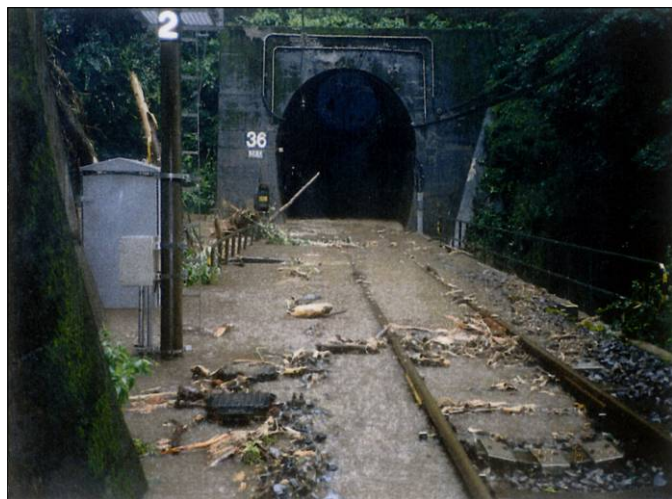
ウルイ沢の土砂流出状況
