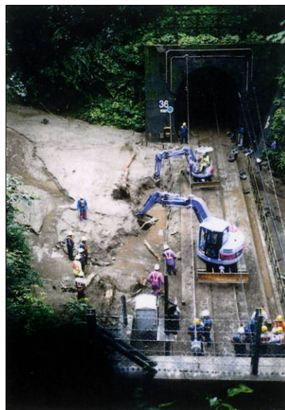
ＪＲ線の復旧作業状況
