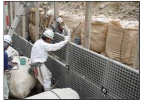
残存型枠を利用した工法
