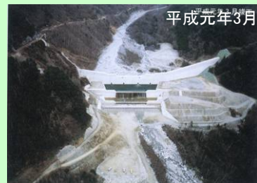
完成直後の滑川第1砂防えん堤
