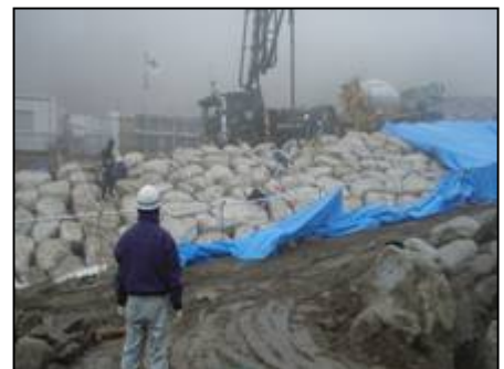
巨石を利用した護岸の整備
