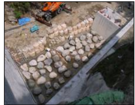
粗石コンクリート工法を利用した水叩工の整備
