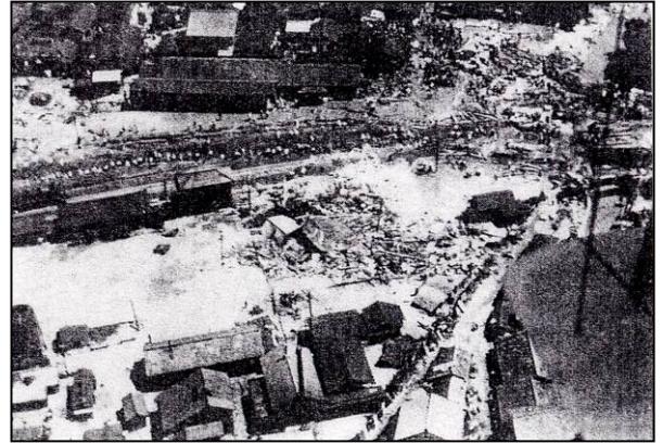
中津川市内の被害状況
