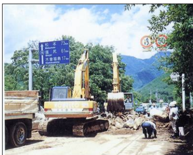
国道19号の復旧作業状況
