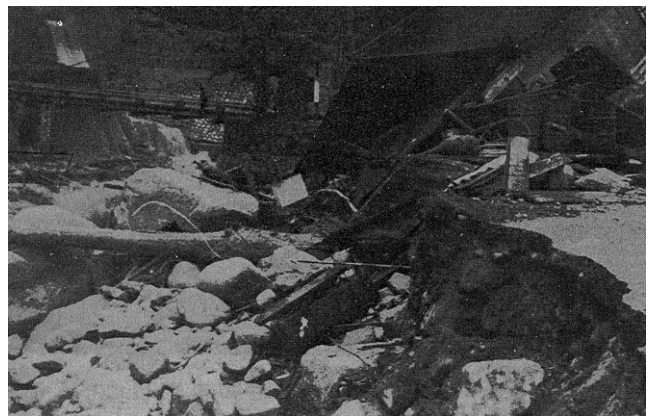
川上地区の被災状況 〈出典：「50年の歩み」〉
