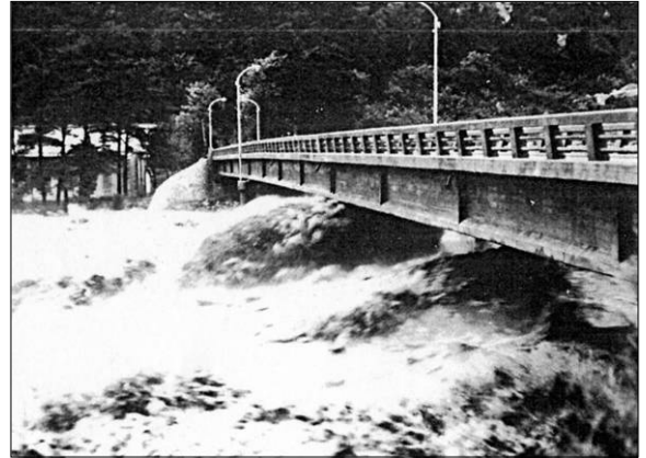
南木曽橋の主桁にせまる濁流 〈出典：「中部の水害」〉
