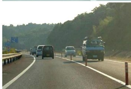
暫定供用区間(勝山IC～鵜沼IC)の状況
