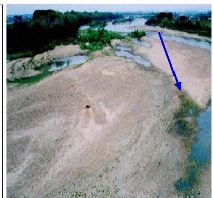
平成13年5月濁水時の水枯れ状態 天神橋（岩津付近） （下流より上流を望む）
