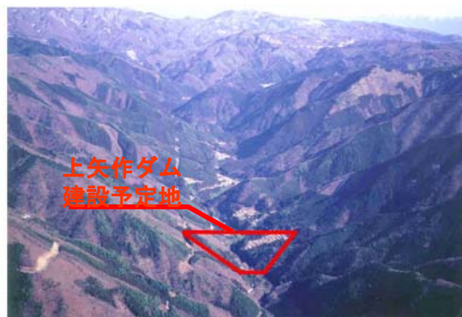
下流よりダムサイト付近を望む（矢作川河口から約100Km、矢作ダムから上流へ約20Km）
