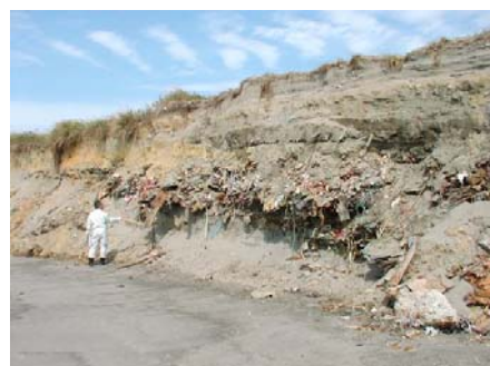
砂丘に埋立てたゴミが海岸侵食により流出(H15)
