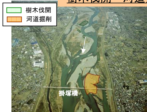
掛塚橋付近の事業実施状況
