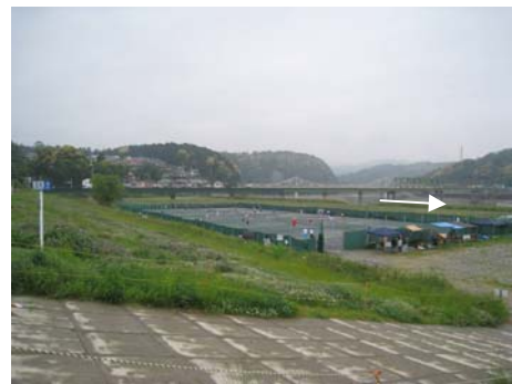
河川公園の基盤整備(浜松市)
