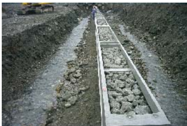
プレキャスト基礎の中詰め材としてCo塊を利用
