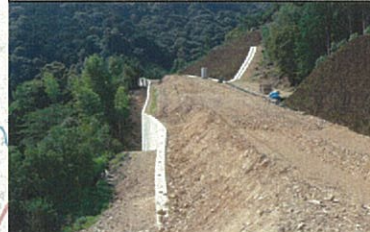
1工区起点付近 道路土工
