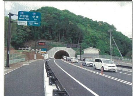
本立野トンネル
